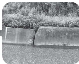
饒波川護岸の陥没状況 ※増水前 (令和4年6月)
