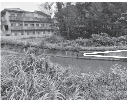
饒波川護岸の陥没状況 ※増水前 (令和4年6月)
