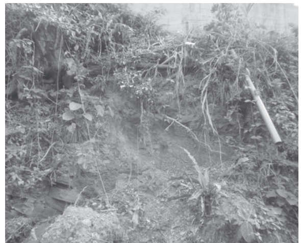
大雨による崩壊状況
