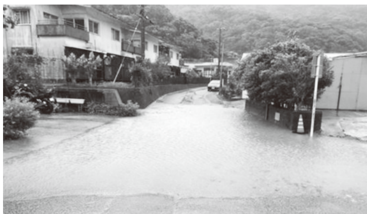
▲大雨・台風時の屋古区入口の冠水状況
